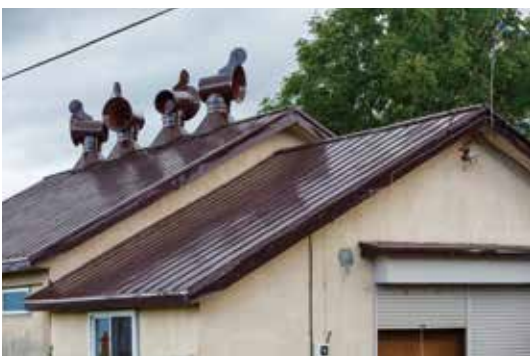
多田ワイナリーに生まれ変わる倉庫。屋根の換気口はタマネギ倉庫の名残り
